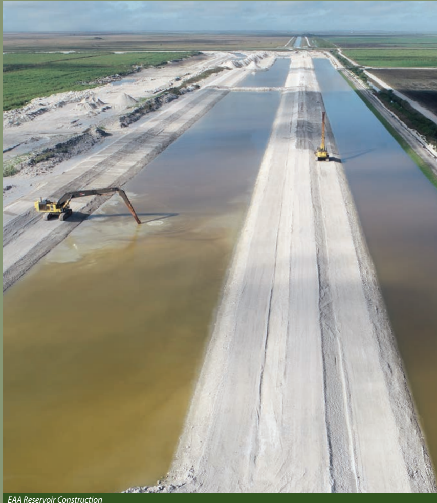
EAA Reservoir Construction
