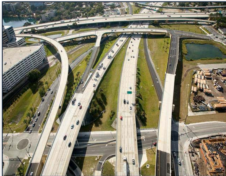
I-4/SR 408 Interim Interchange in Orlando.
